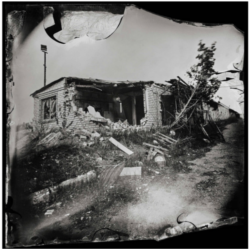
Ruine Cette maison, située à Saltivka, un quartier populaire de Kharkiv, a été touchée par l'artillerie.
