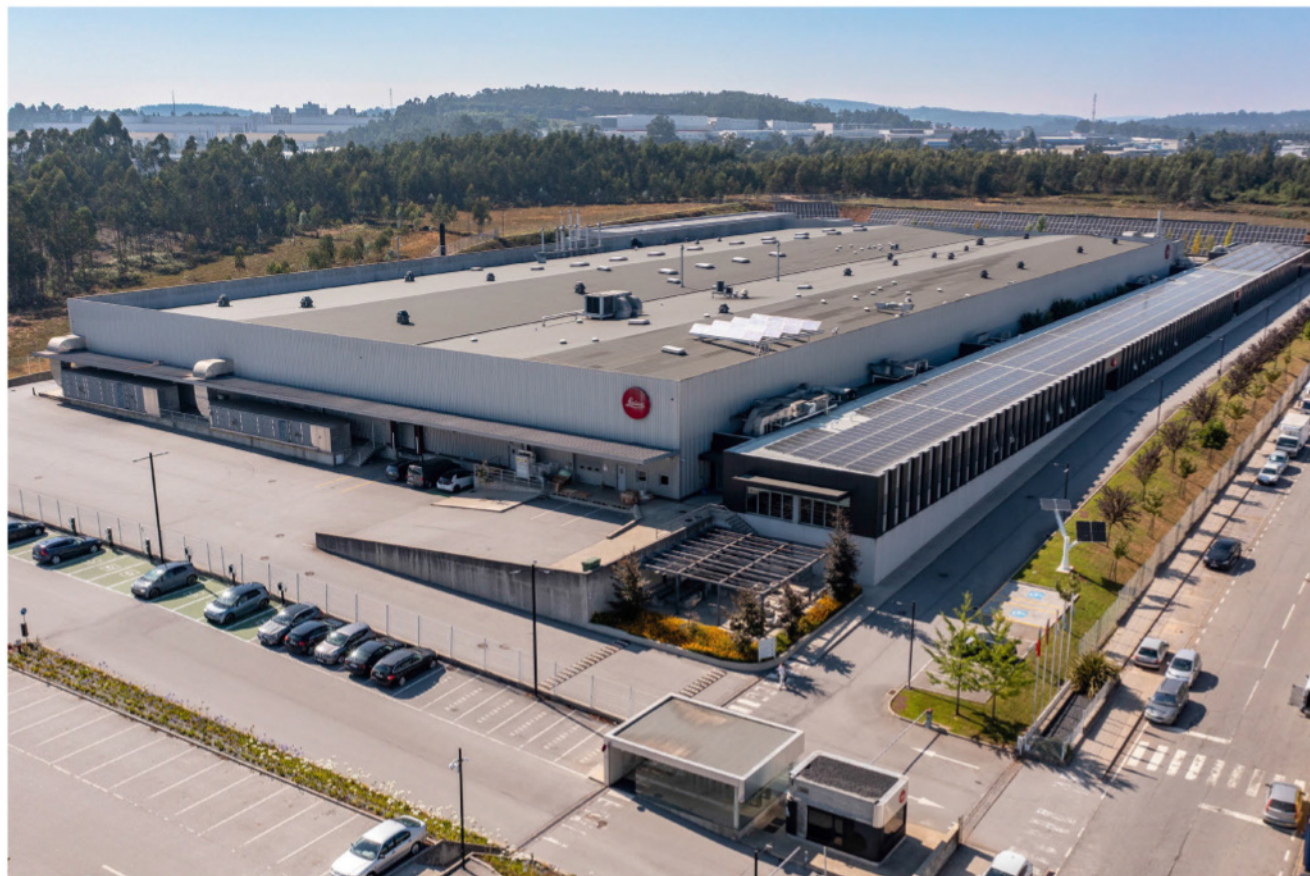
L'usine de Vila Nova de Famalicão a été ouverte en 2013, remplaçant un précédent atelier vieillissant. Sur place, les panneaux solaires couvrent 40 % des besoins énergétiques du site.
